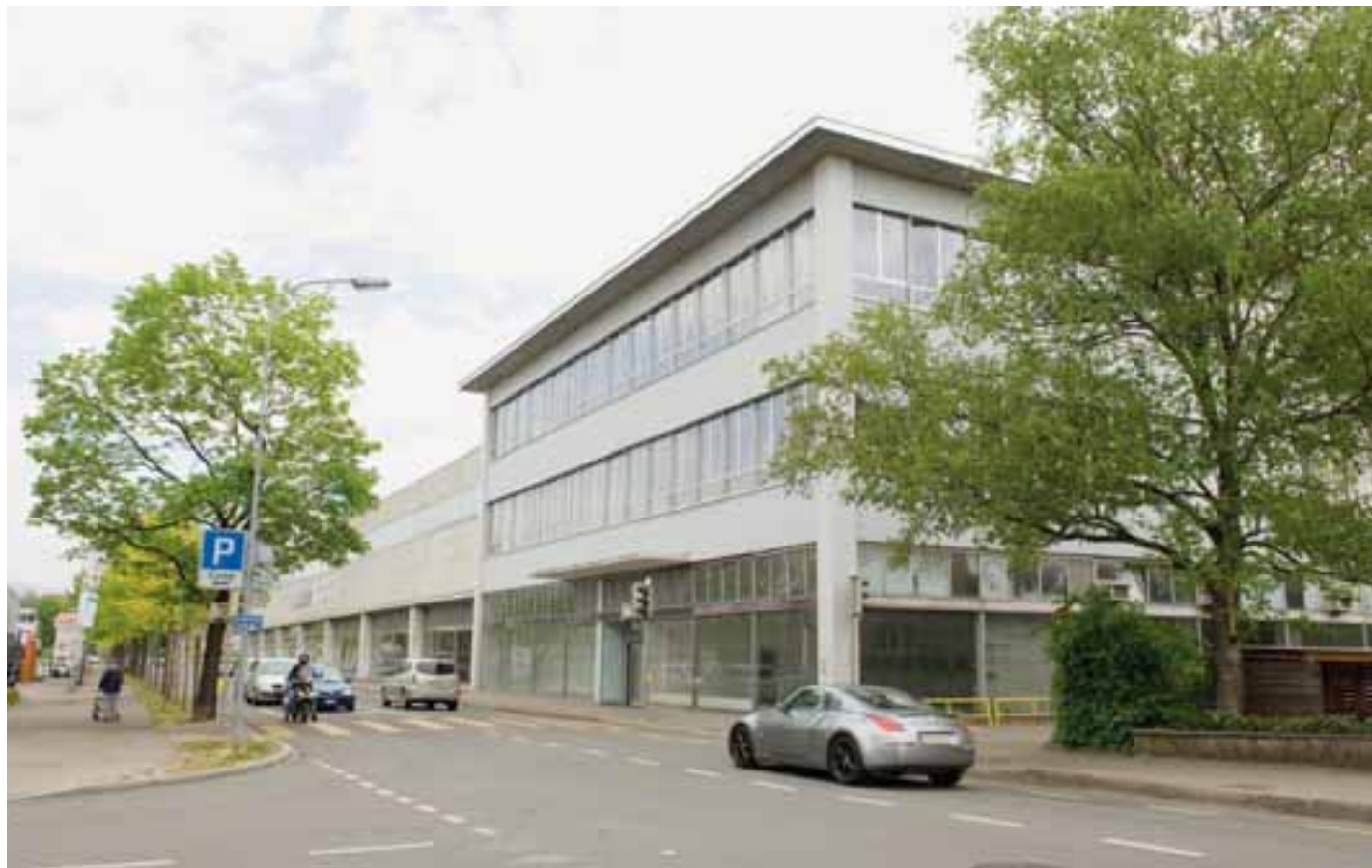
Das alte GM-Gebäude nahe des Bieler Bahnhofs müsste einem A5-Anschluss Biel Zentrum wahrscheinlich weichen. Bild: Peter Samuel Jaggi
