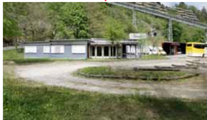
In der Seevorstadt sind ein halbes Dutzend Häuser bedroht.
